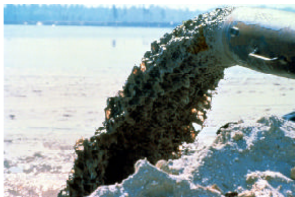
Dredge discharge pipe
